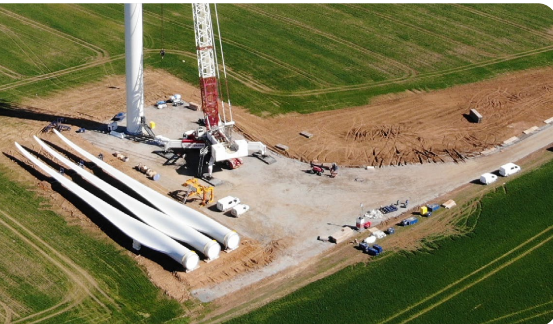
Parc éolien de Berceronne Photo : © CAMEO
